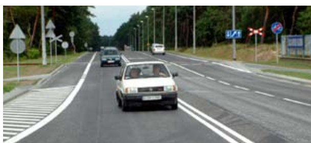
Modernizacje dróg i rozbudowa układu komunikacyjnego
