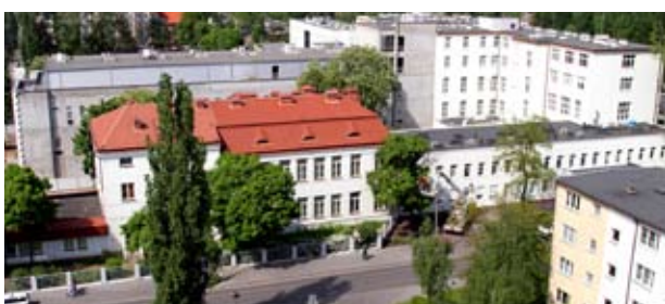
Rozbudowa Specjalistycznego Szpitala Miejskiego - modernizacja bloków operacyjnych
