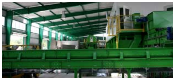
Zakład unieszkodliwiania odpadów komunalnych - instytucja przyjazna środowisku
