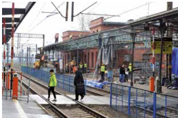
Remont dworca Toruń Główny
