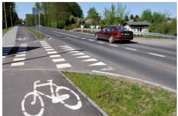
Rozbudowa ul. Nieszawskiej (2014)
