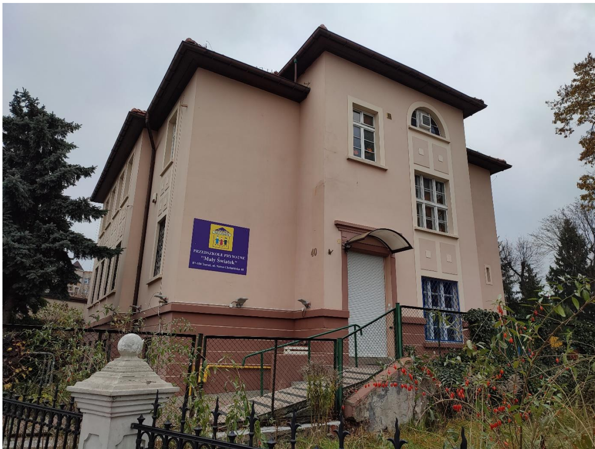
Fotografia 2. Widok na budynek przedszkola zlokalizowany przy ul. Szosa Chełmińska 40 – obiekt ujęty w Gminnej Ewidencji Zabytków
