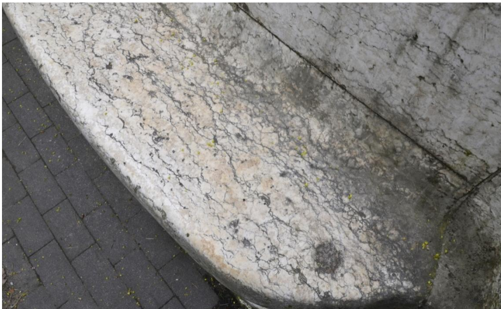
Fot. 7. Ławka Schillera, stan zachowania, widoczne nawarstwienia aglomeracyjne i mikrobiologiczne nagromadzone w naturalnych szczelinach charakterystycznych dla złoża.
