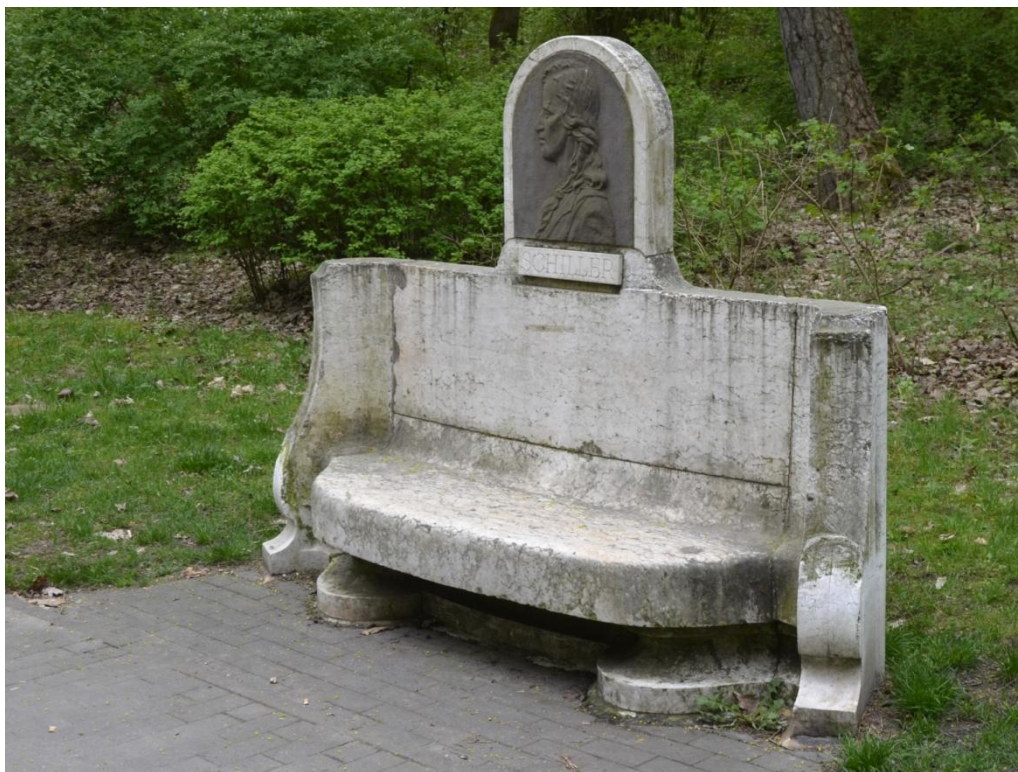
Fot.2. Ławka Schillera, ogólny stan zachowania. Widoczne zanieczyszczenie powierzchni przybierające formę zacieków oraz nawarstwień nagromadzonych w zagłębieniach formy
