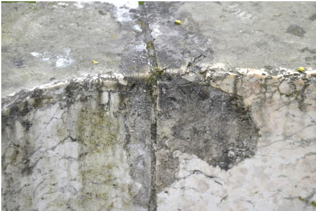
Fot. 10. Ławka Schillera, łączenie bloków siedziska i oparcia - widoczne uzupełnienie ubytku formy wprowadzone w czasie ostatniej renowacji, obecnie pociemniałe i odspojone.
