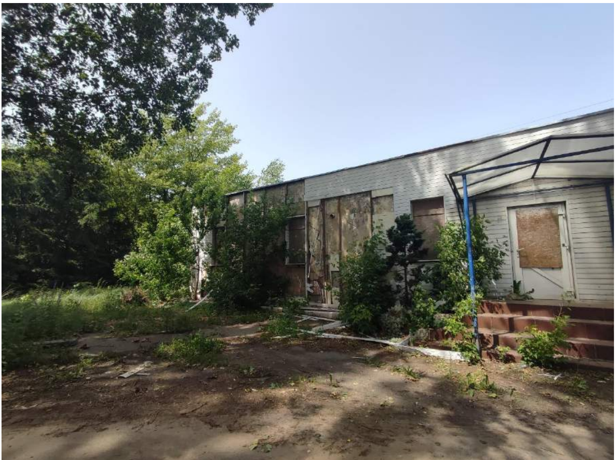
Fotografia 6. Nieużytkowany, zniszczony budynek w północno-zachodniej części obszaru
