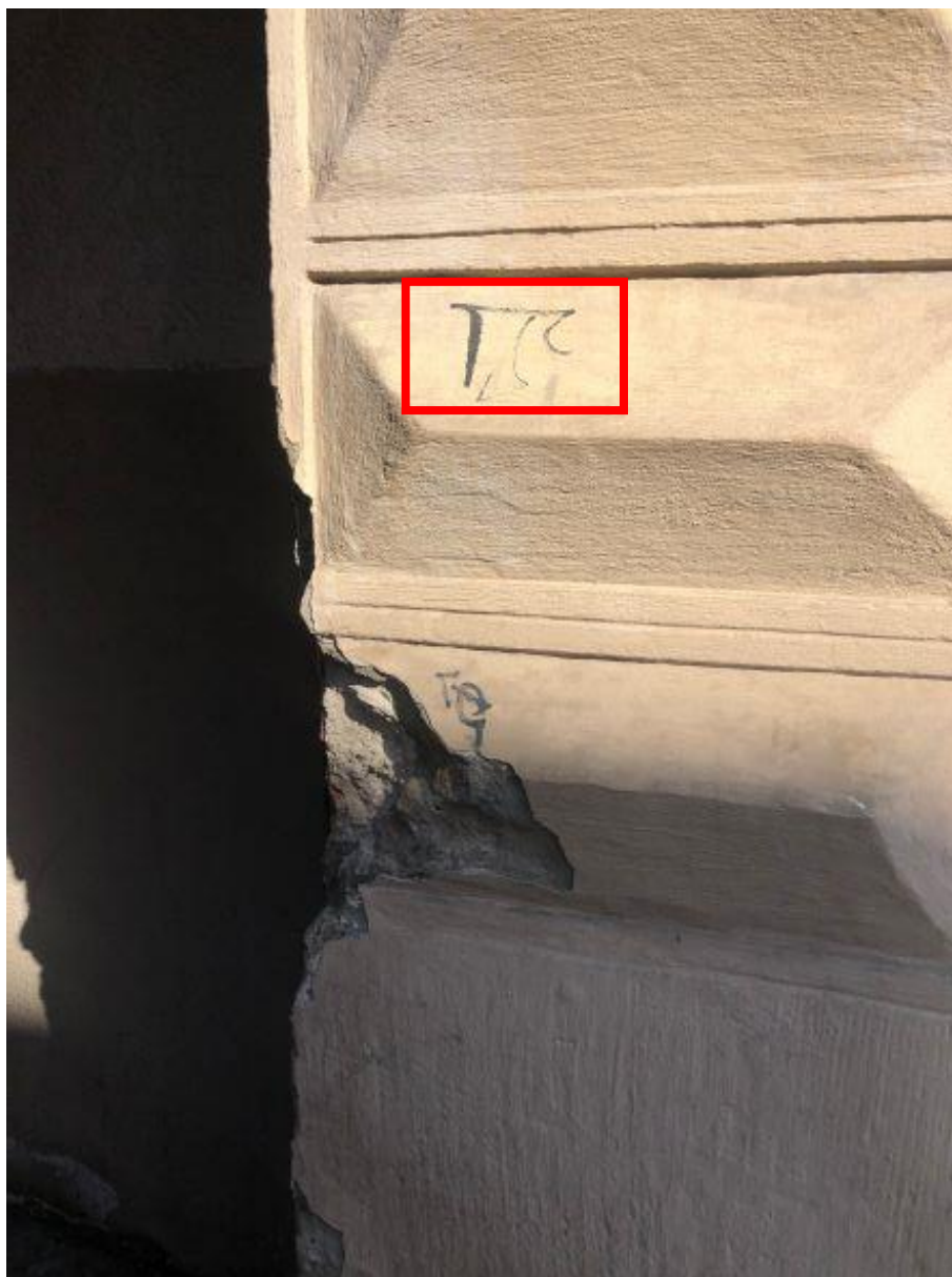
43. Fragment ściany kamienicy pod Łukiem Cezara.
