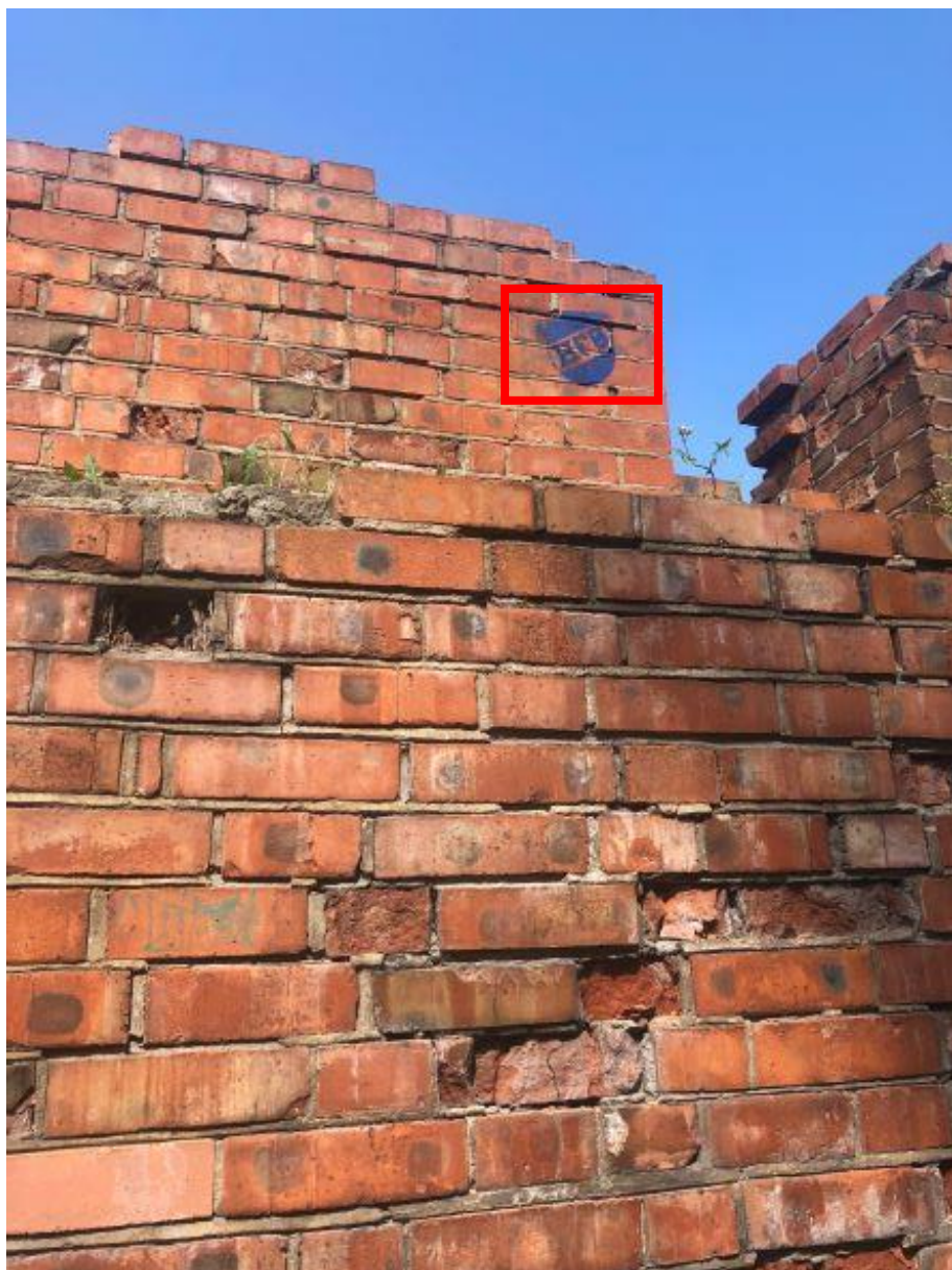
6. Korona muru obok budynku przy ul. Wały gen. Sikorskiego 12, strona zachodnia.
