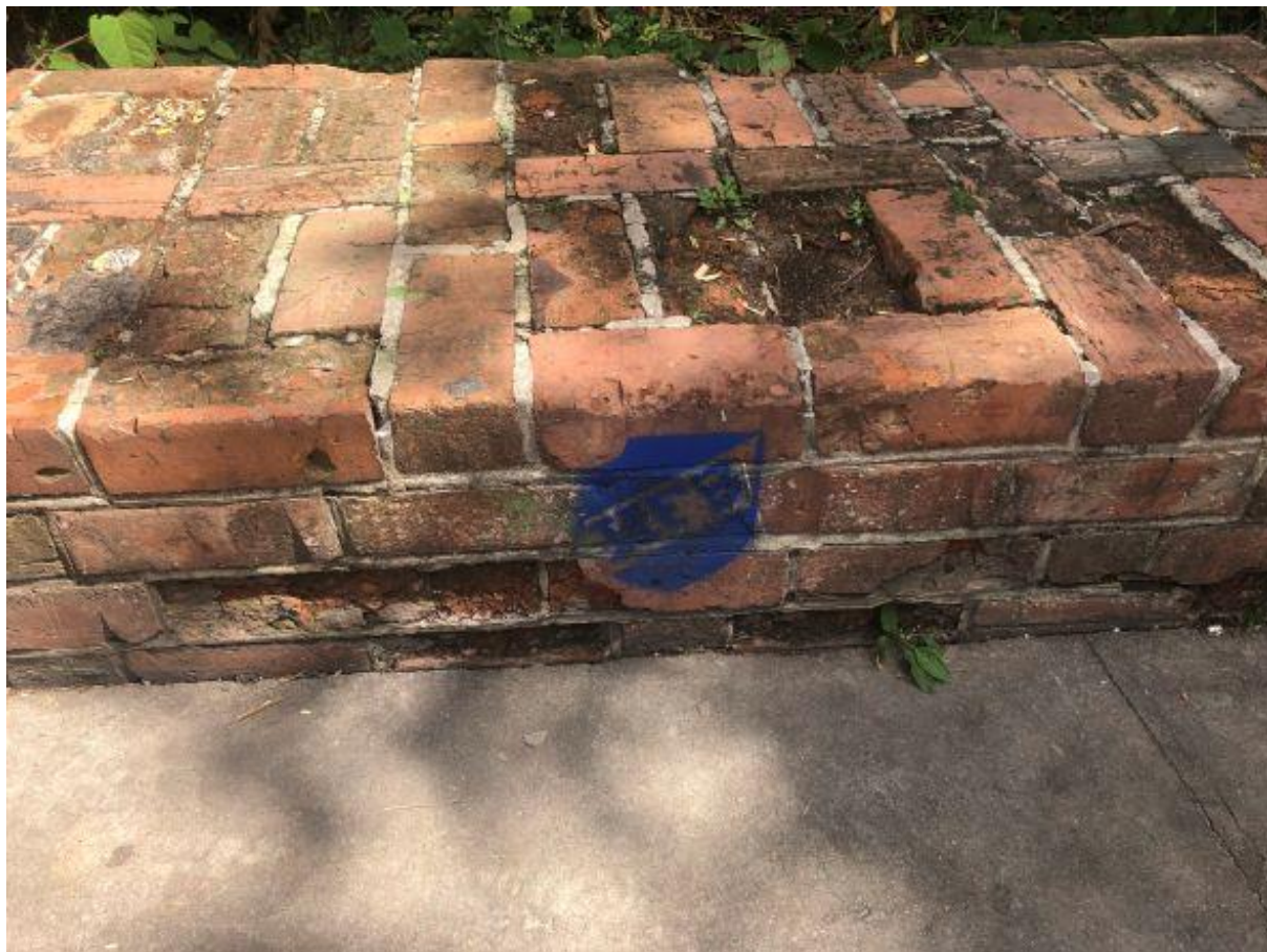
8. Fragment niskiego murku obok budynku przy ul. Wały gen. Sikorskiego 12
