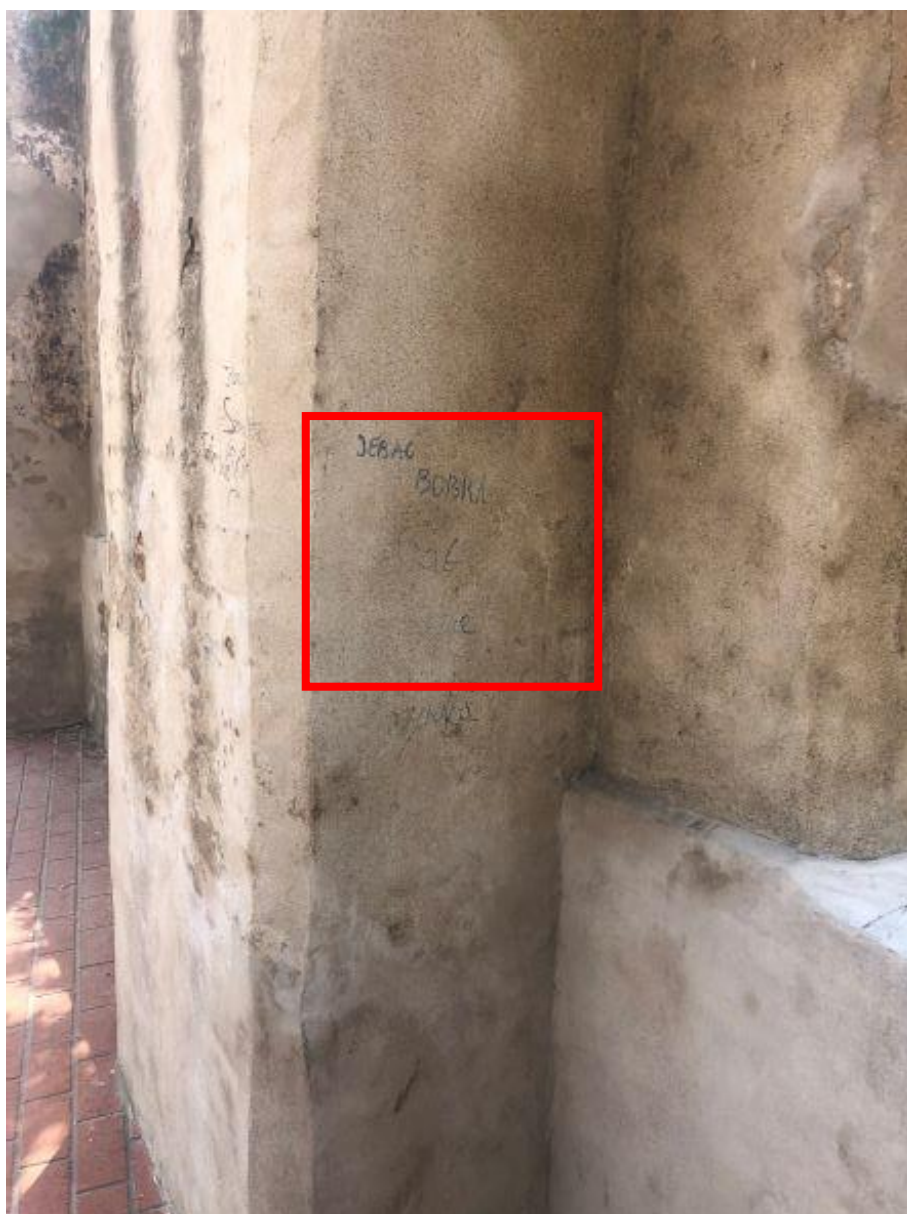
20. Ściana zachodniej dawnej kaplicy klasztornej św. Katarzyny, Plac Podominikański.
