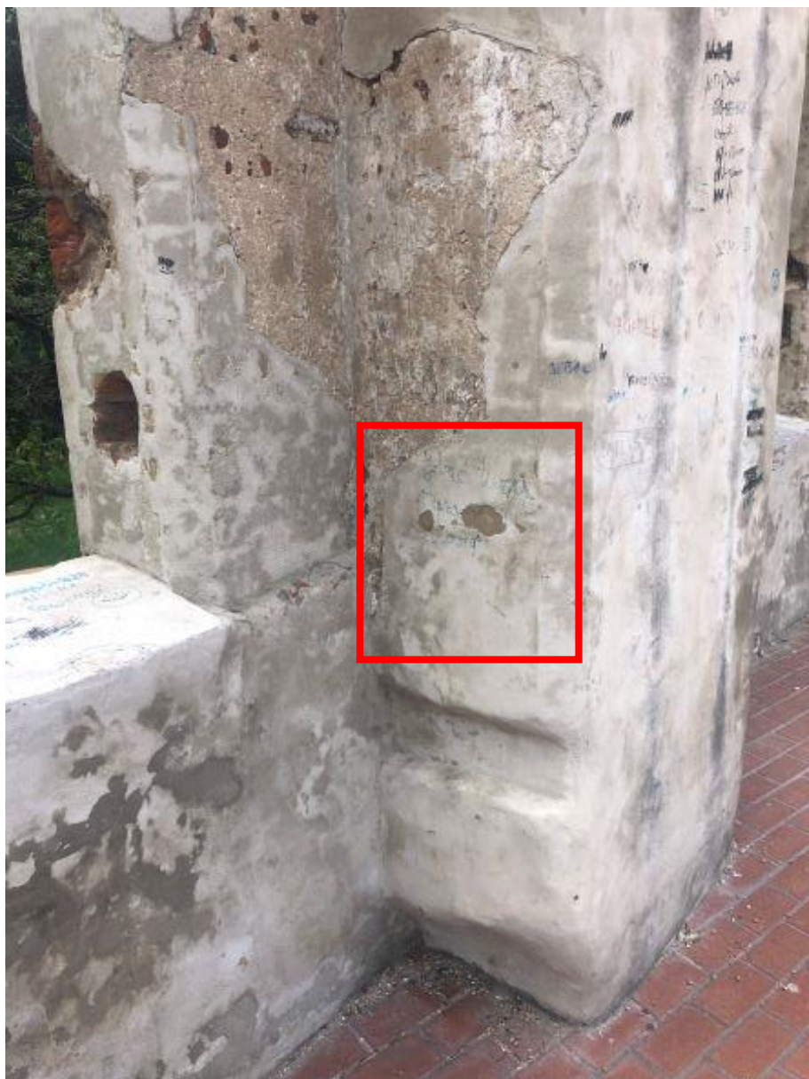
13. Ściana zachodniej dawnej kaplicy klasztornej św. Katarzyny, Plac Podominikański.
