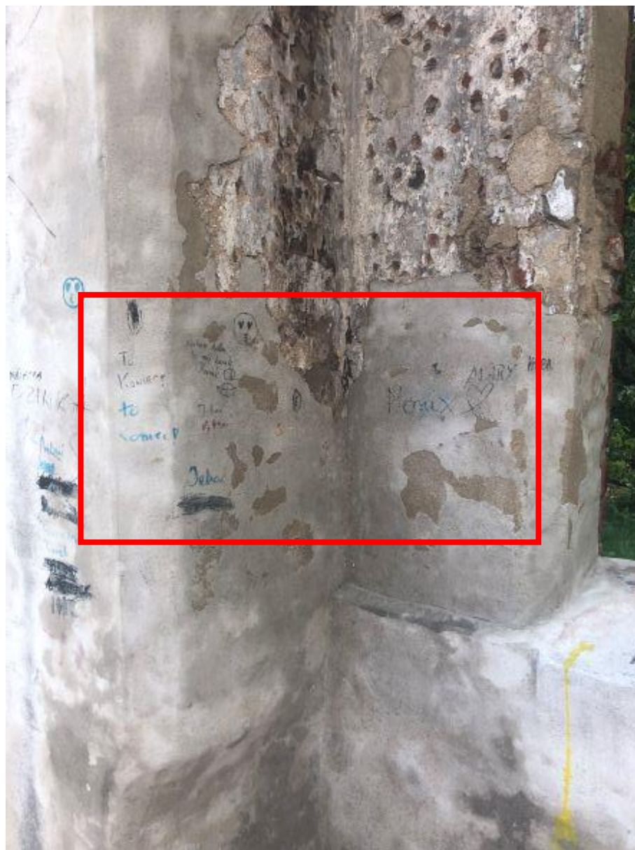
15. Ściana zachodniej dawnej kaplicy klasztornej św. Katarzyny, Plac Podominikański.
