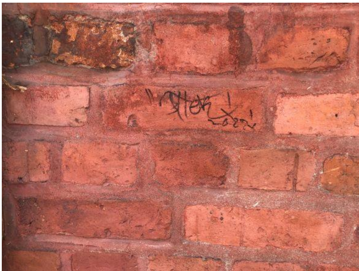
23. Fragment muru wzdłuż ul. Dominikańskiej.
