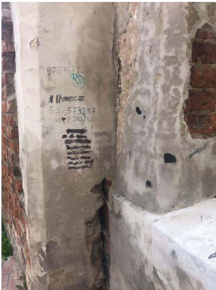
11. Ściana zachodniej dawnej kaplicy klasztornej św. Katarzyny, Plac Podominikański.
