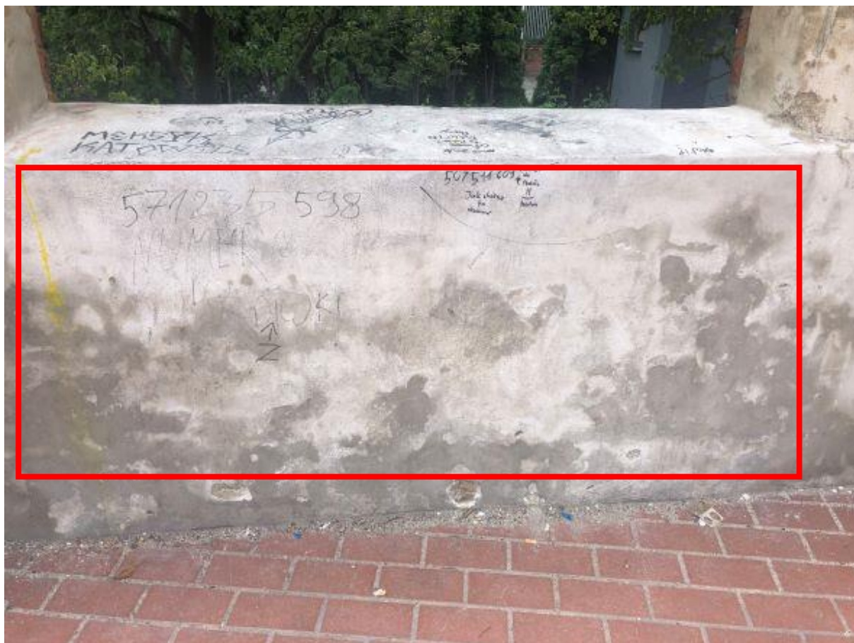
16. Ściana zachodniej dawnej kaplicy klasztornej św. Katarzyny, Plac Podominikański.
