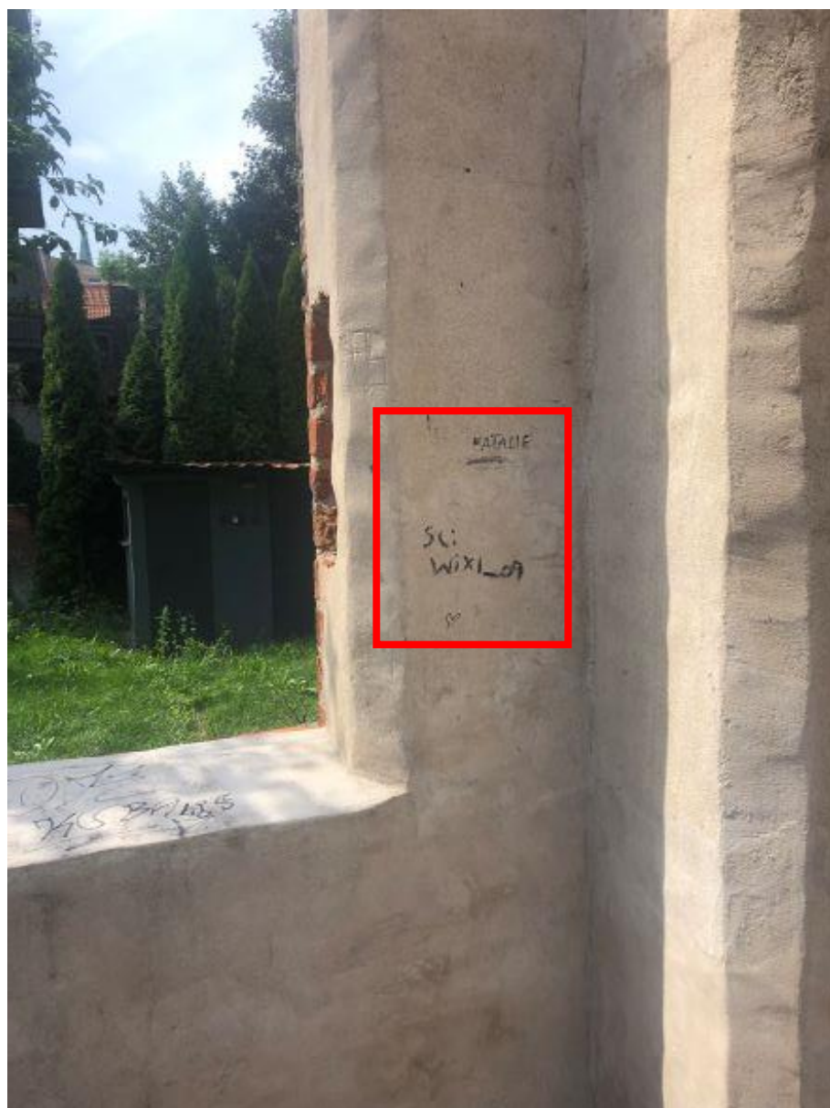
22. Ściana zachodniej dawnej kaplicy klasztornej św. Katarzyny, Plac Podominikański.
