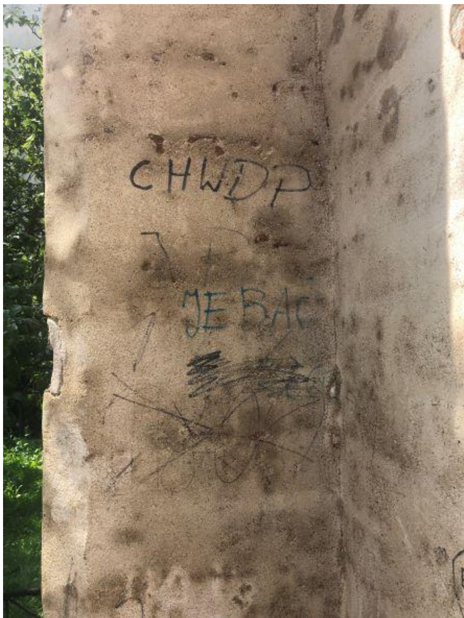
18. Ściana zachodniej dawnej kaplicy klasztornej św. Katarzyny, Plac Podominikański.
