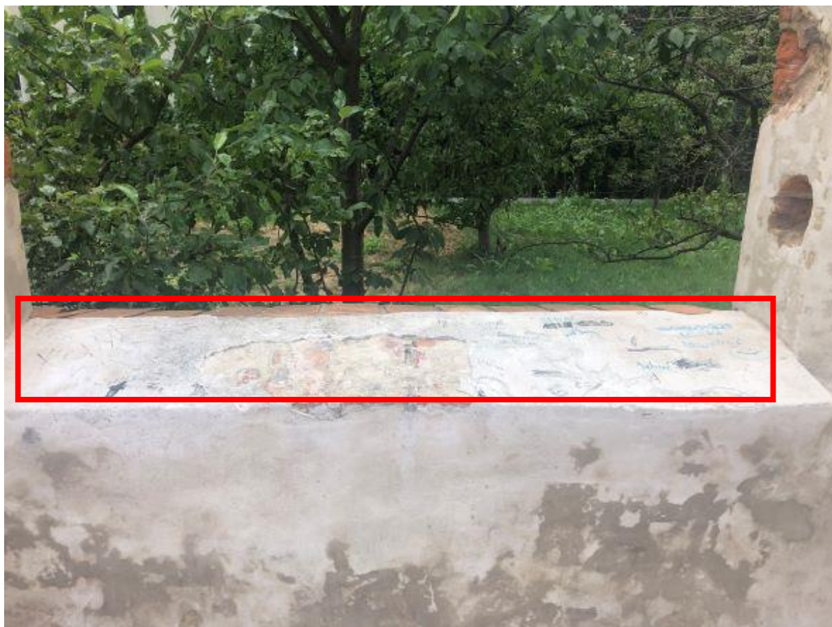
12. Ściana zachodniej dawnej kaplicy klasztornej św. Katarzyny, Plac Podominikański.
