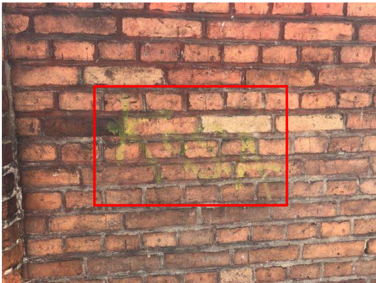
26. Fragment muru wzdłuż ulicy Dominikańskiej.
