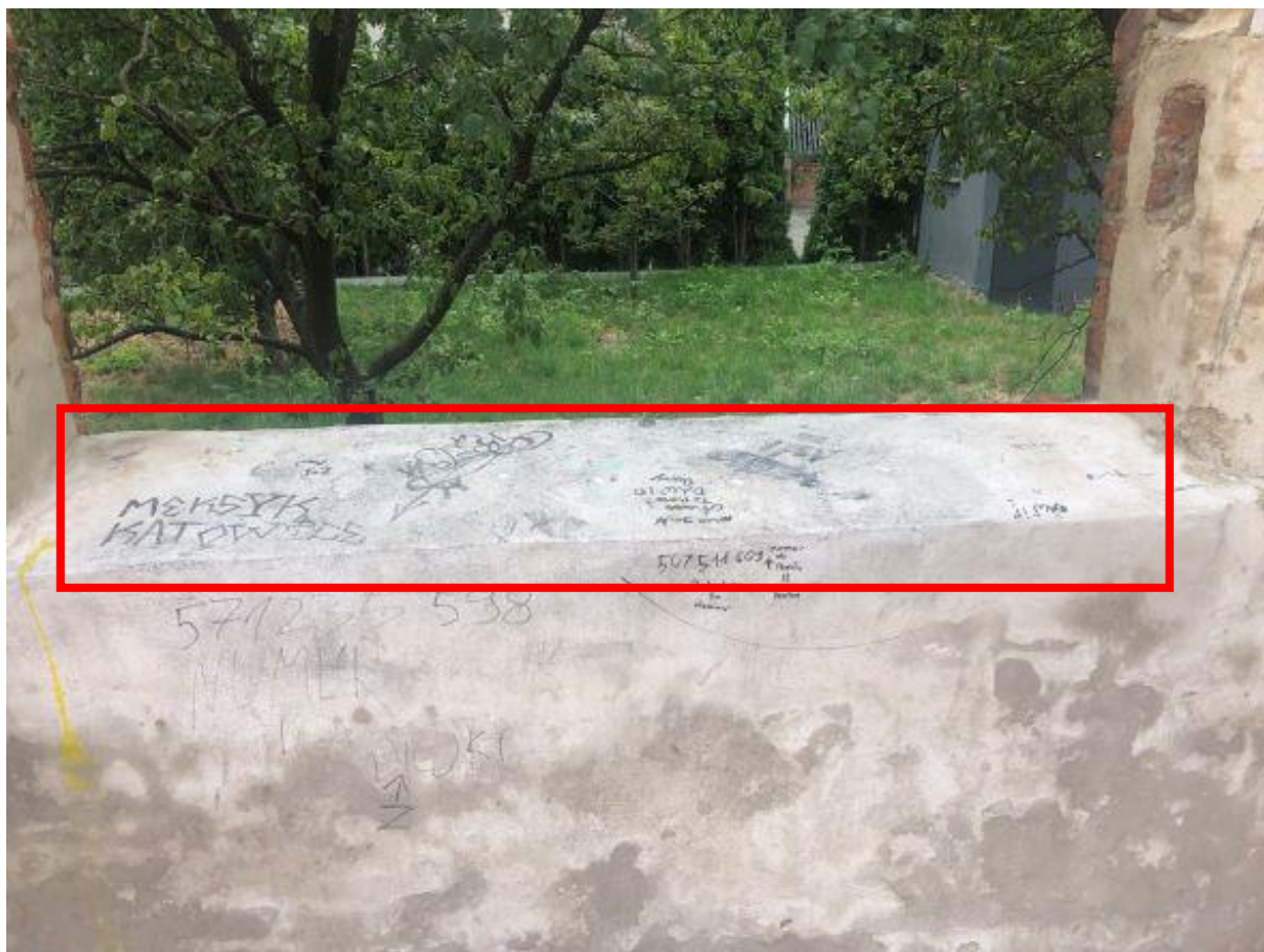
17. Ściana zachodniej dawnej kaplicy klasztornej św. Katarzyny, Plac Podominikański.
