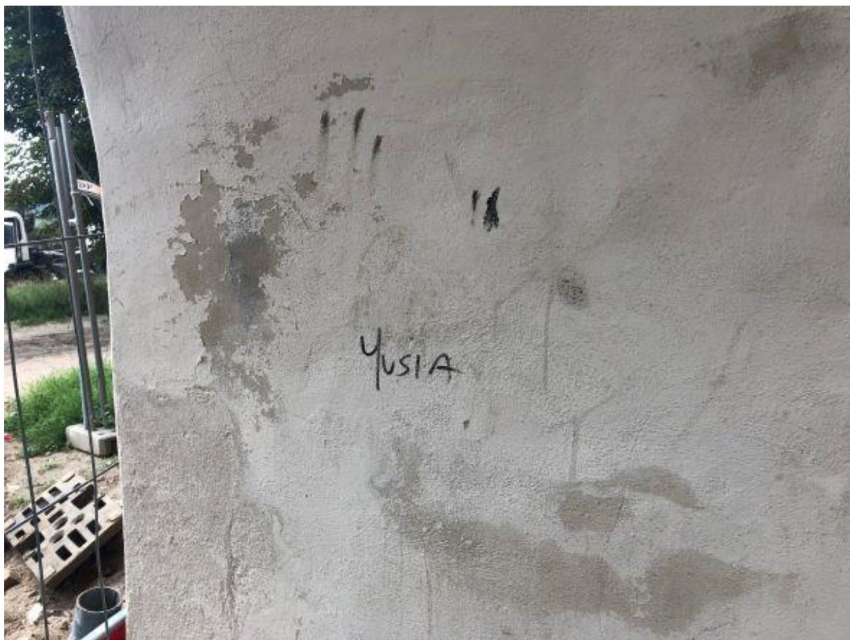
39. Brama Mostowa, przejście po stronie zachodniej.
