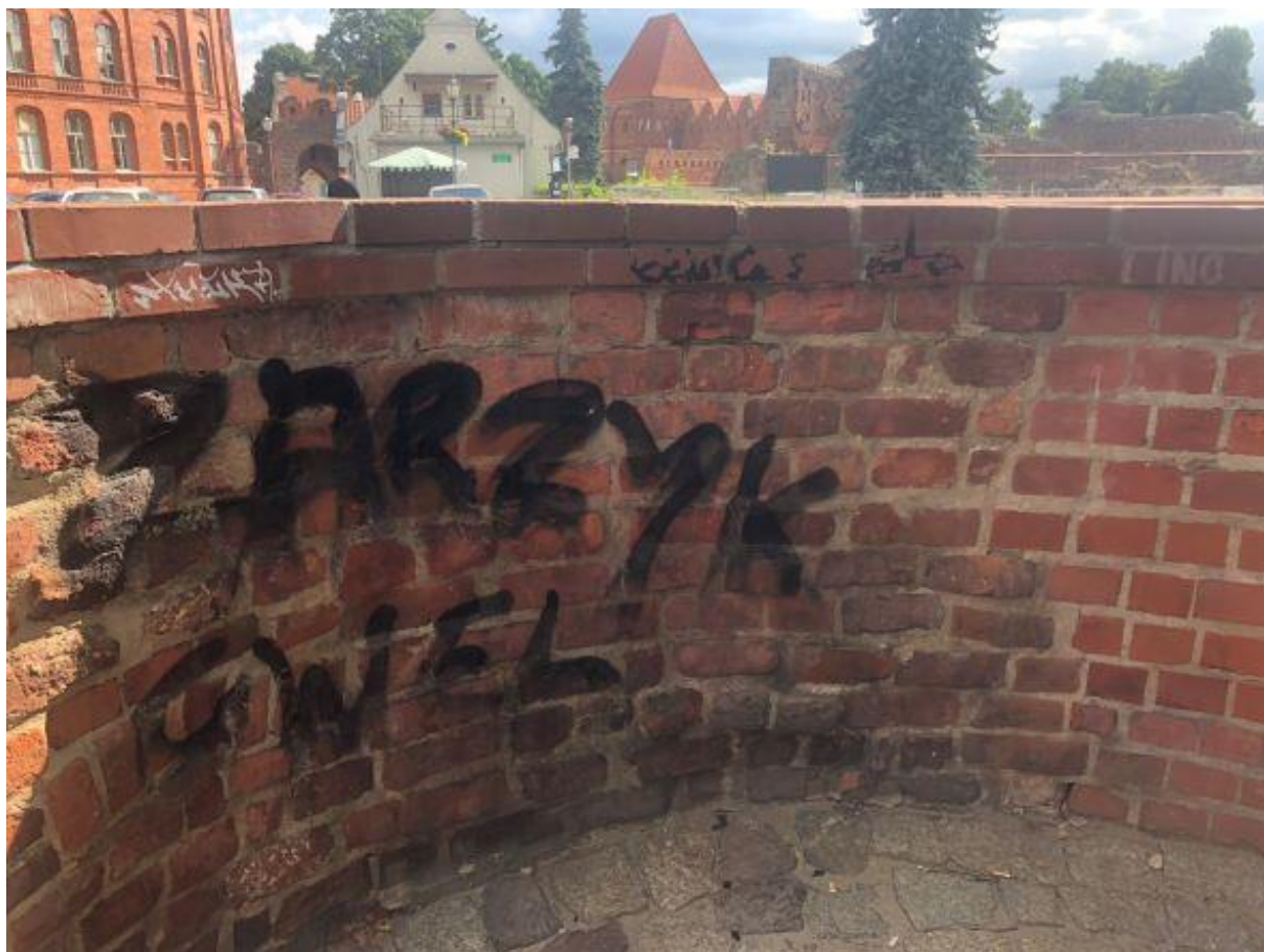
51. Fragment muru baszty w zachodniej fosie zamkowej przy schodach, od strony zachodniej
