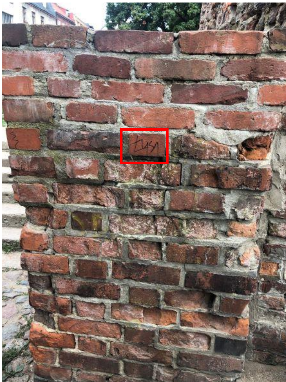
50. Fragment muru baszty w zachodniej fosie zamkowej przy schodach, od strony zachodniej
