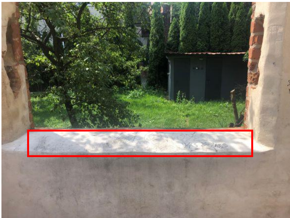
21. Ściana zachodniej dawnej kaplicy klasztornej św. Katarzyny, Plac Podominikański.
