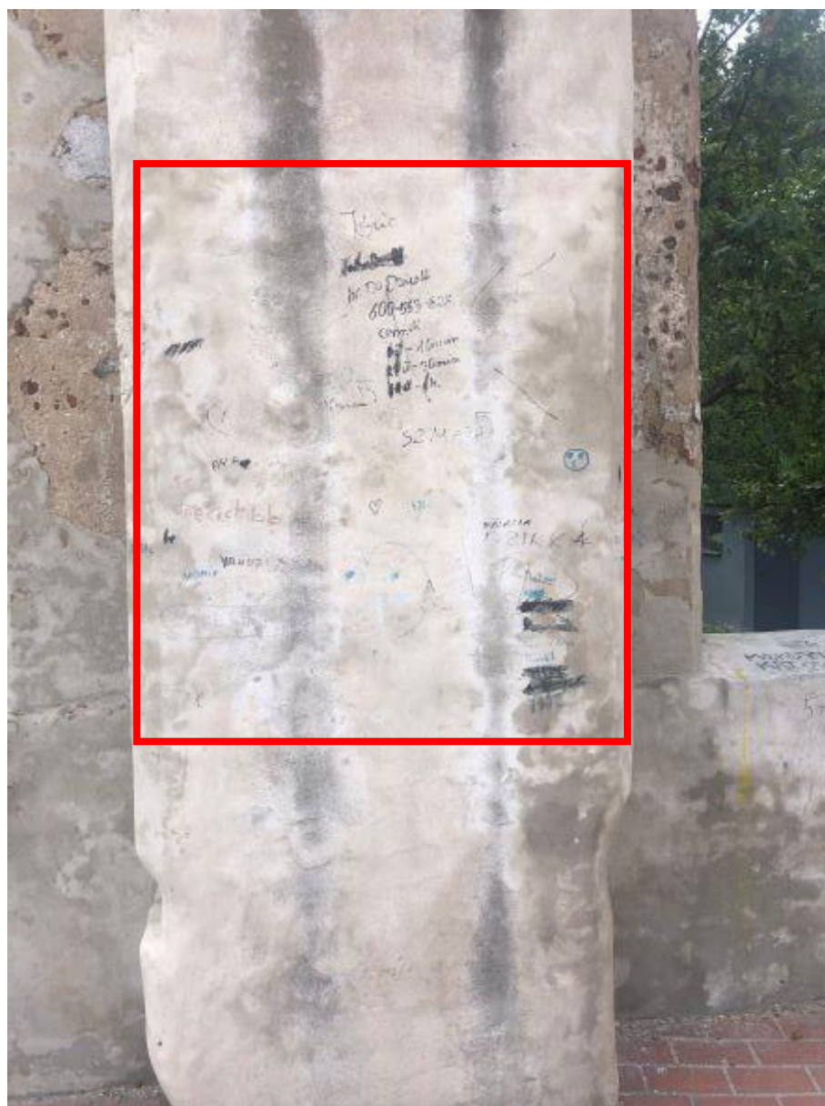
14. Ściana zachodniej dawnej kaplicy klasztornej św. Katarzyny, Plac Podominikański.
