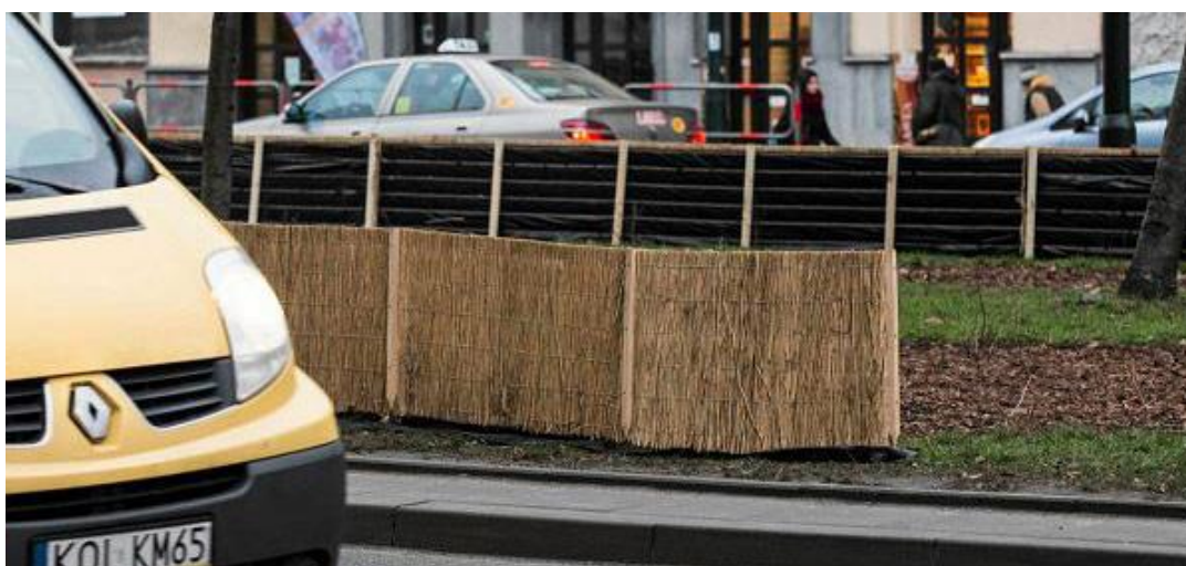
Fot. 7. Osłony słomiano-wiklinowe o wys. 60 cm montowane za pomocą palików w gruncie.
