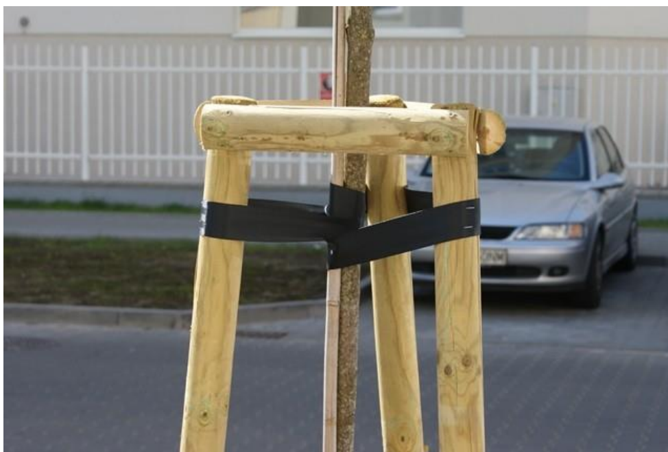
Fot. 5. Sposób palikowania drzew.
