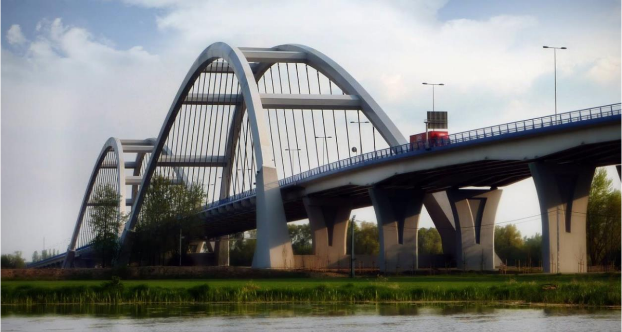
Fot. 4 Trasa mostowa – źródło emisji hałasu i spalin
