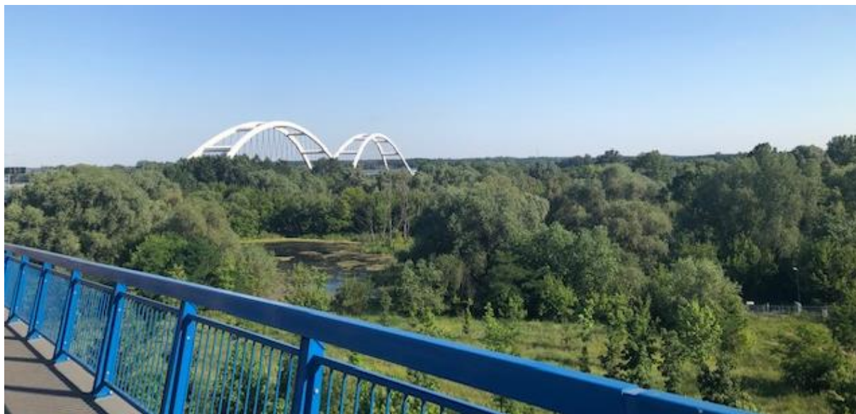
Fot.1. Tereny położone po zachodniej stronie od mostu
