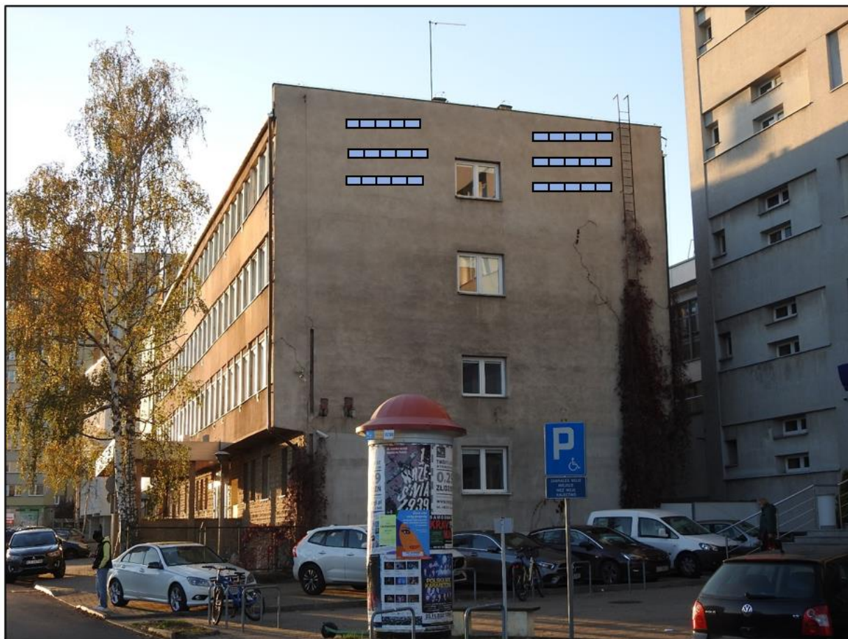
Ryc. 11. Oznaczenie miejsc montażu skrzynek lęgowych.
