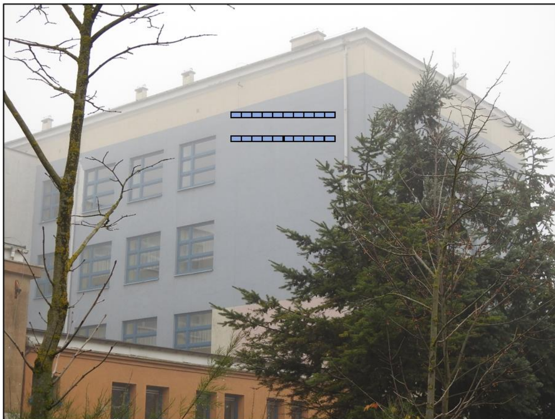
Ryc. 2. Oznaczenie miejsc montażu skrzynek lęgowych.
