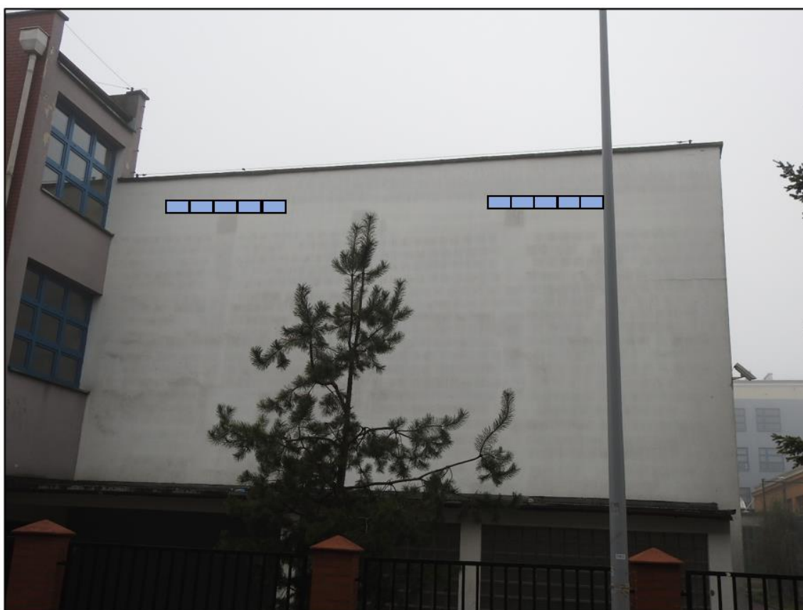
Ryc. 3. Oznaczenie miejsc montażu skrzynek lęgowych.
