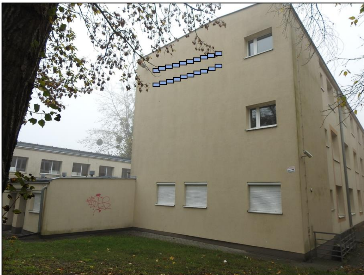
Ryc. 9. Oznaczenie miejsc montażu skrzynek lęgowych.
