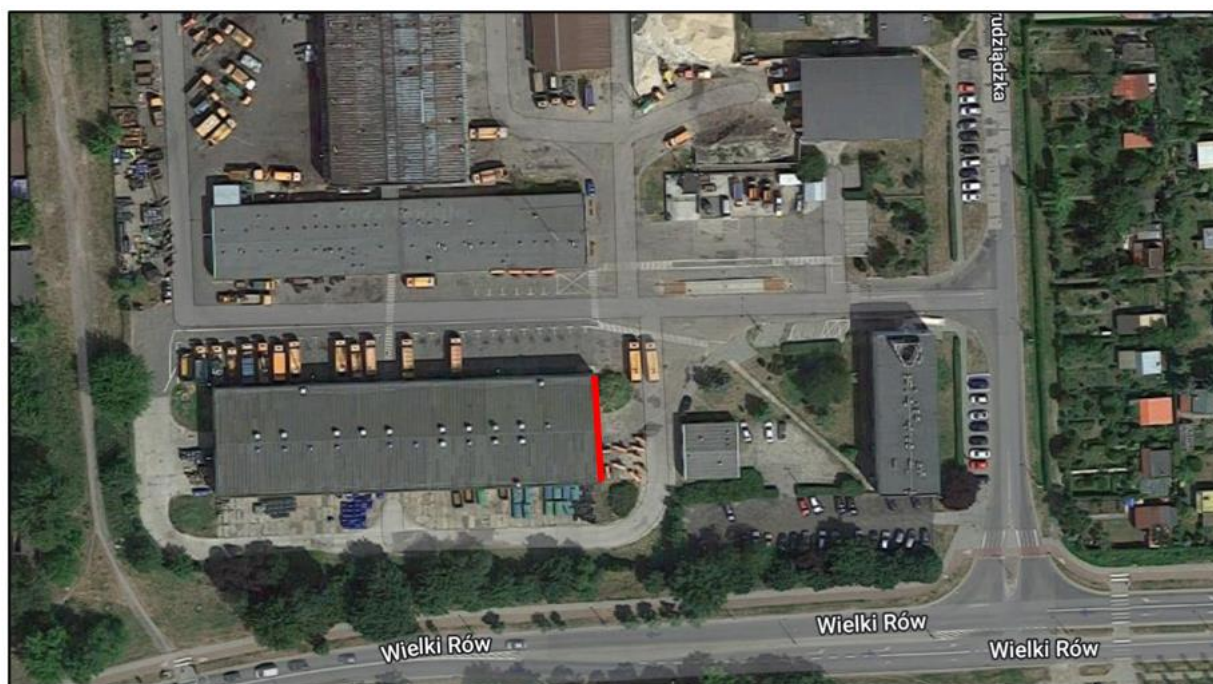
Ryc. 12. Oznaczenie miejsc montażu skrzynek lęgowych.
