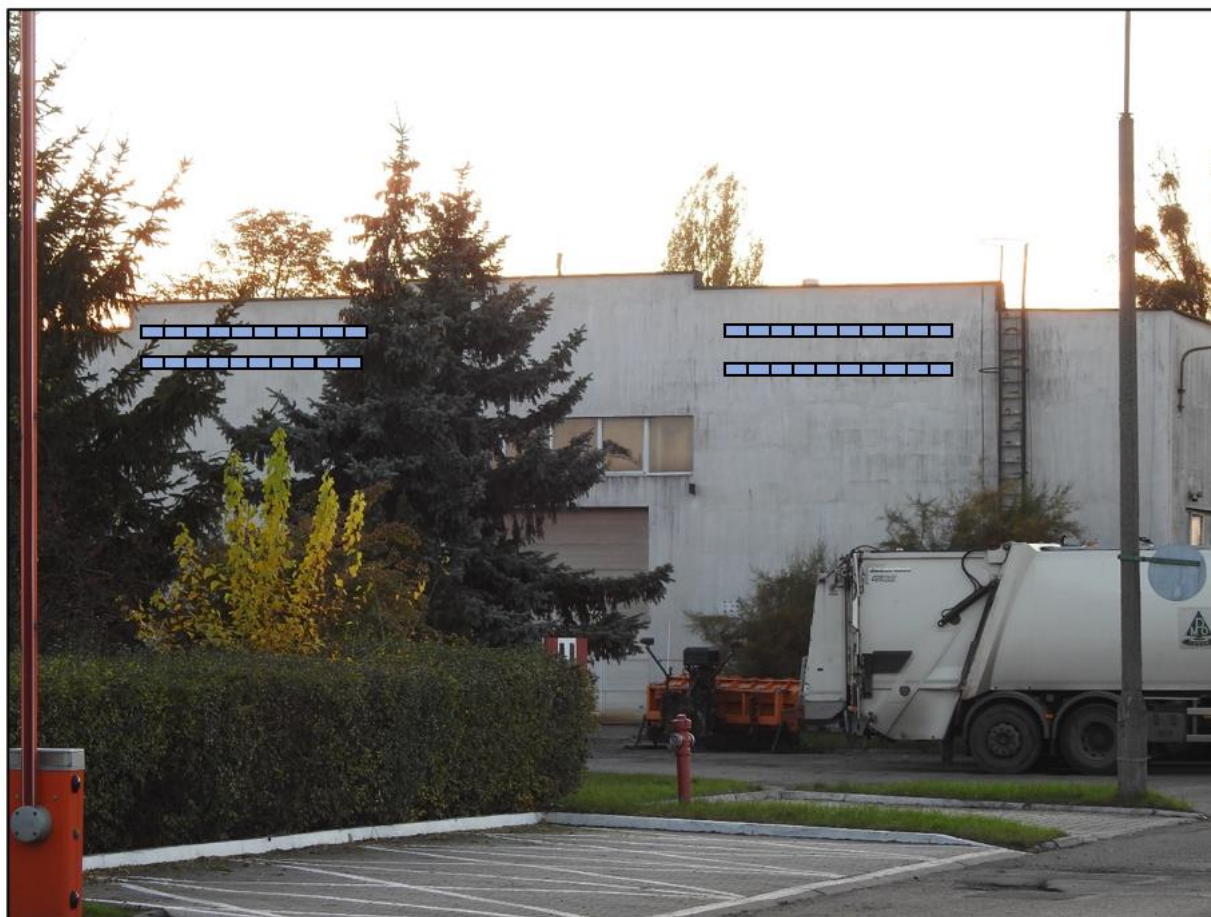
Ryc. 13. Oznaczenie miejsc montażu skrzynek lęgowych.
