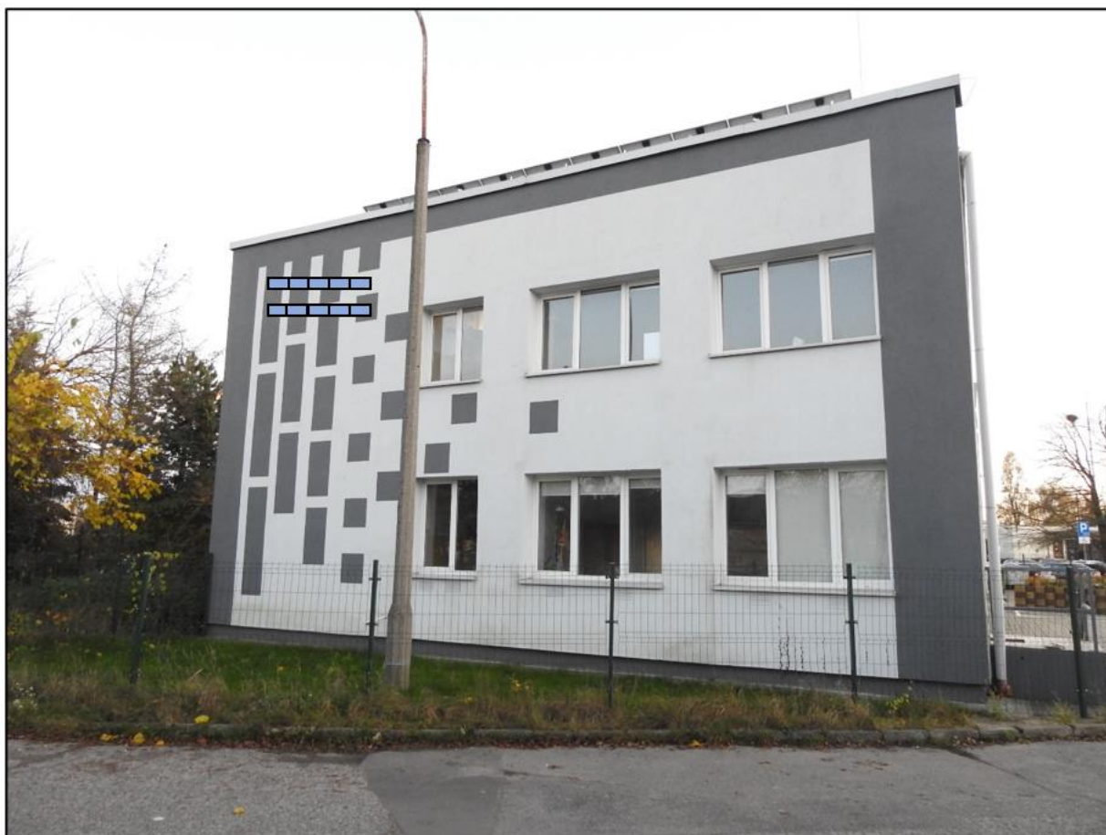
Ryc. 15. Oznaczenie miejsc montażu skrzynek lęgowych.
