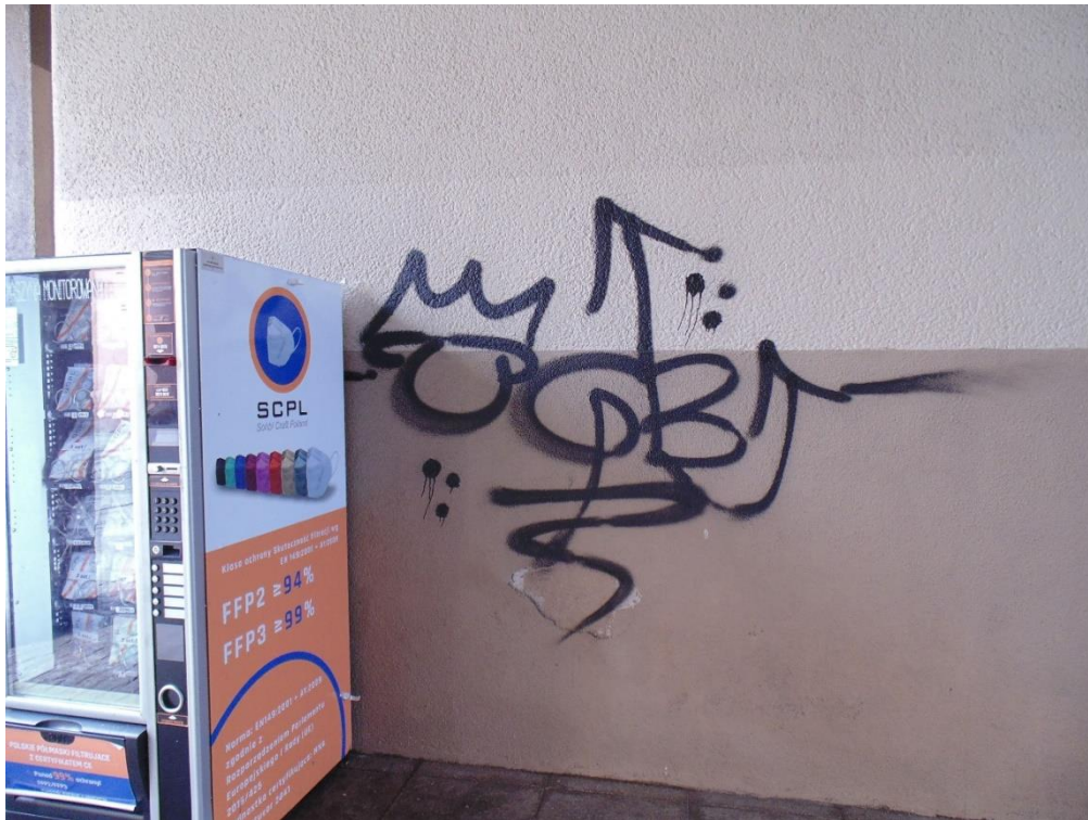
24. Fragment ściany kamienicy pod Łukiem Cezara po stronie południowej.
