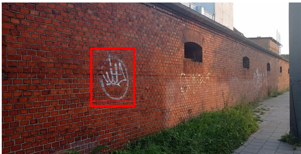
49. Fragment muru Fortu Przyczółek Mostowy, ul. Podgórska, strona północna.
