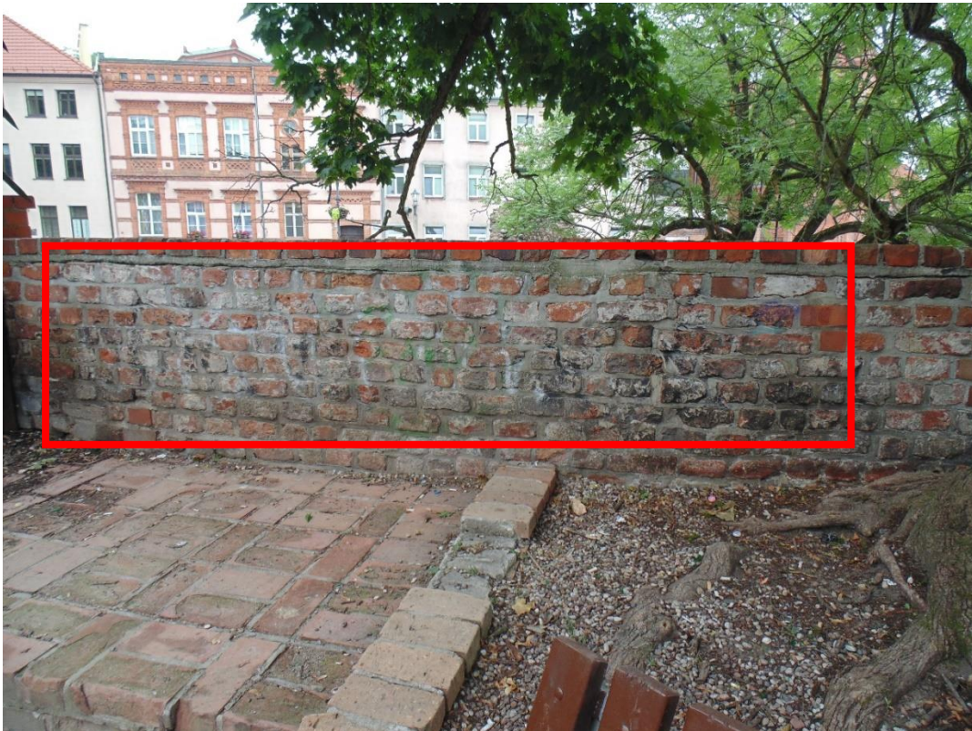
15. Fragment muru w ogrodzie kamiennym przy ul. Podmurnej od strony wschodniej.
