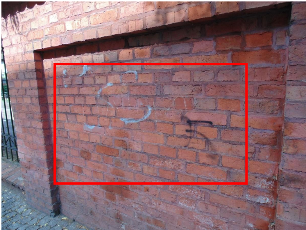
41. Fragment muru wzdłuż ul. Zaulek Prosowy.
