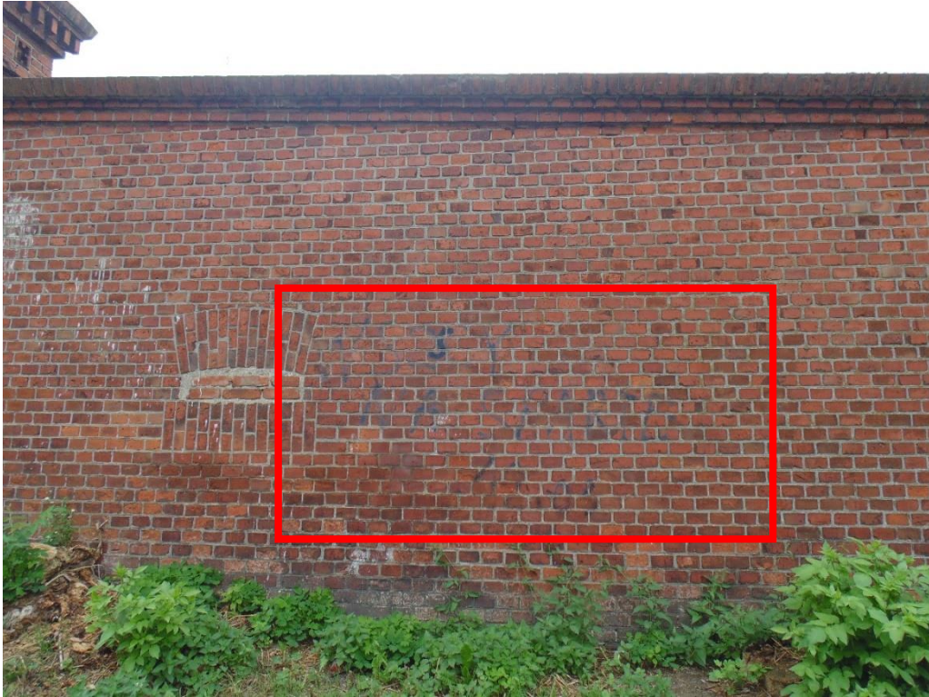
22. Fragment muru przy ul. Św. Jakuba po stronie północnej.
