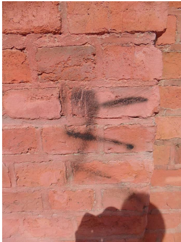
39. Fragment muru wzdłuż ul. Zaulek Prosowy.
