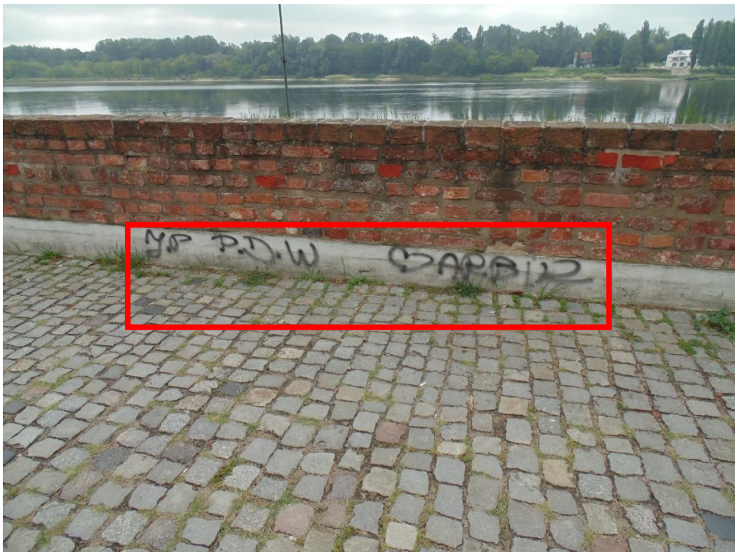
17. Fragment muru przy ul. Bulwar Filadelfijski na wysokości Zamku krzyżackiego, od strony północnej.
