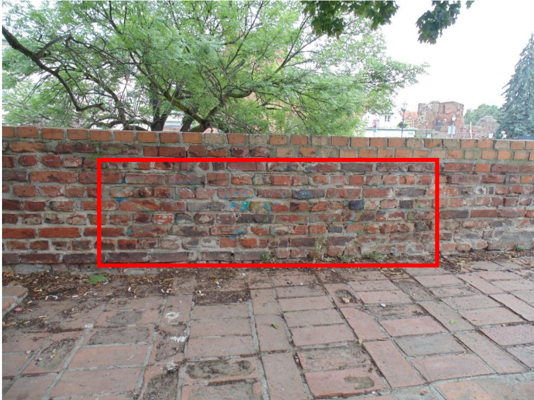
13. Fragment muru w ogrodzie kamiennym przy ul. Podmurnej od strony wschodniej.
