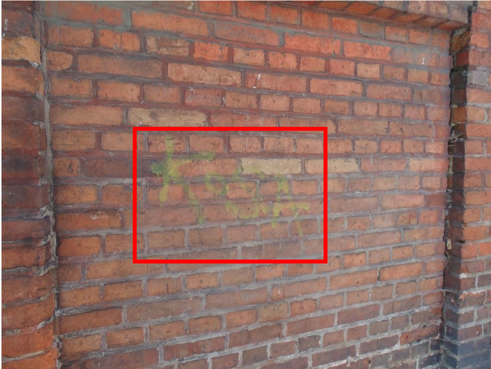
40. Fragment muru wzdłuż ul. Zaulek Prosowy.
