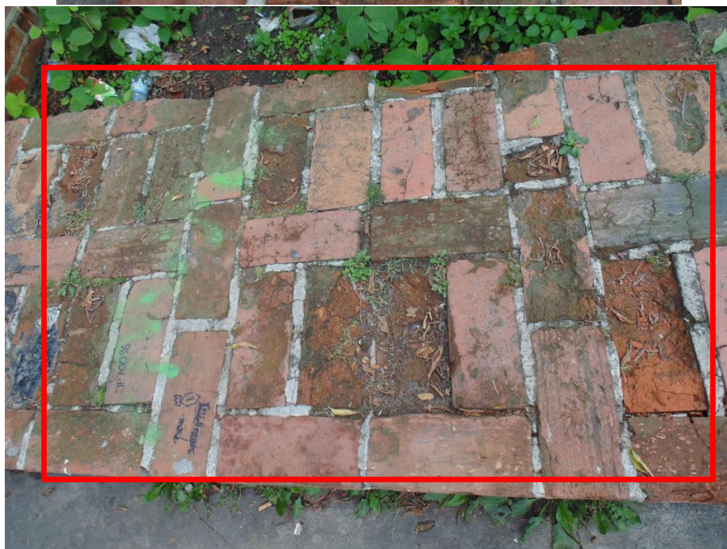
35. Zwieńczenie murku obok budynku przy ul. Wały gen. Sikorskiego 12.
