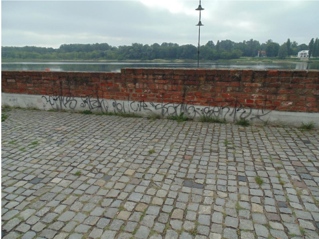
18. Fragment muru przy ul. Bulwar Filadelfijski na wysokości Zamku krzyżackiego, od strony północnej.
