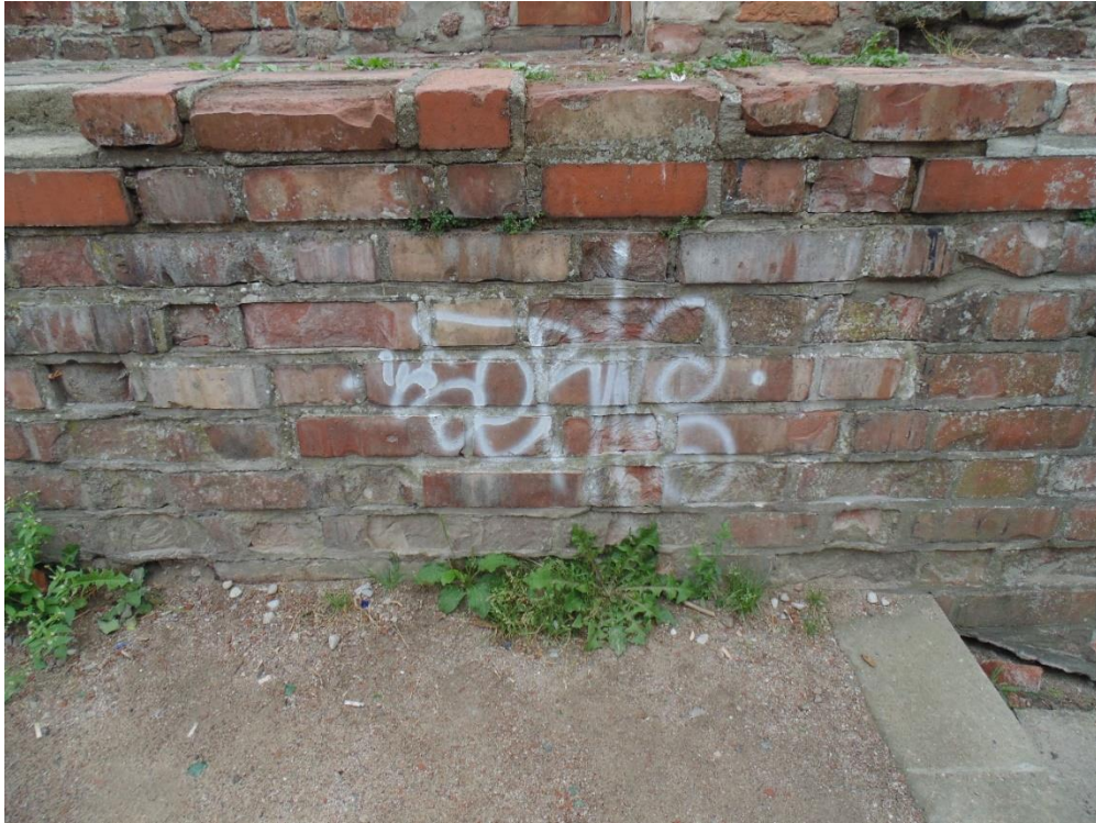
11. Fragment muru w ogrodzie kamiennym przy ul. Podmurnej od strony wschodniej.
