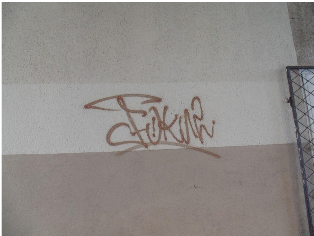
25. Fragment ściany kamienicy pod Łukiem Cezara po stronie południowej.
