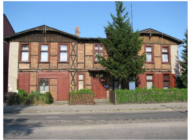
Dom szkieletowy, współczesne naprawy naroży, zachowany detal (okiennice, stolarka) [ul. Szosa Chełmińska 62–64]
