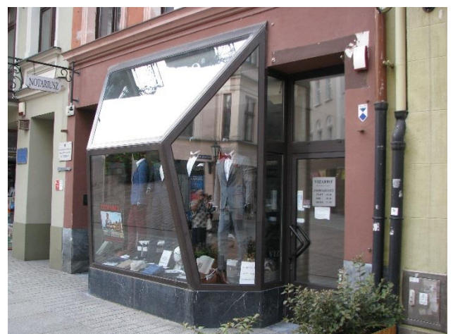
Awangardowa witryna sklepowa z lat. 90. XX w. [ul. Wielkie Garbary 21]
