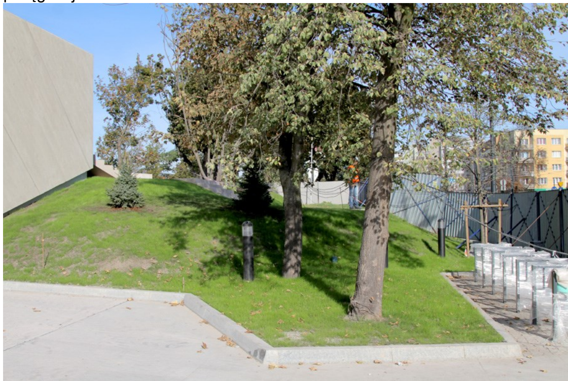
Fot. 53. Zielony dach pionu technicznego CCK Jordanki
