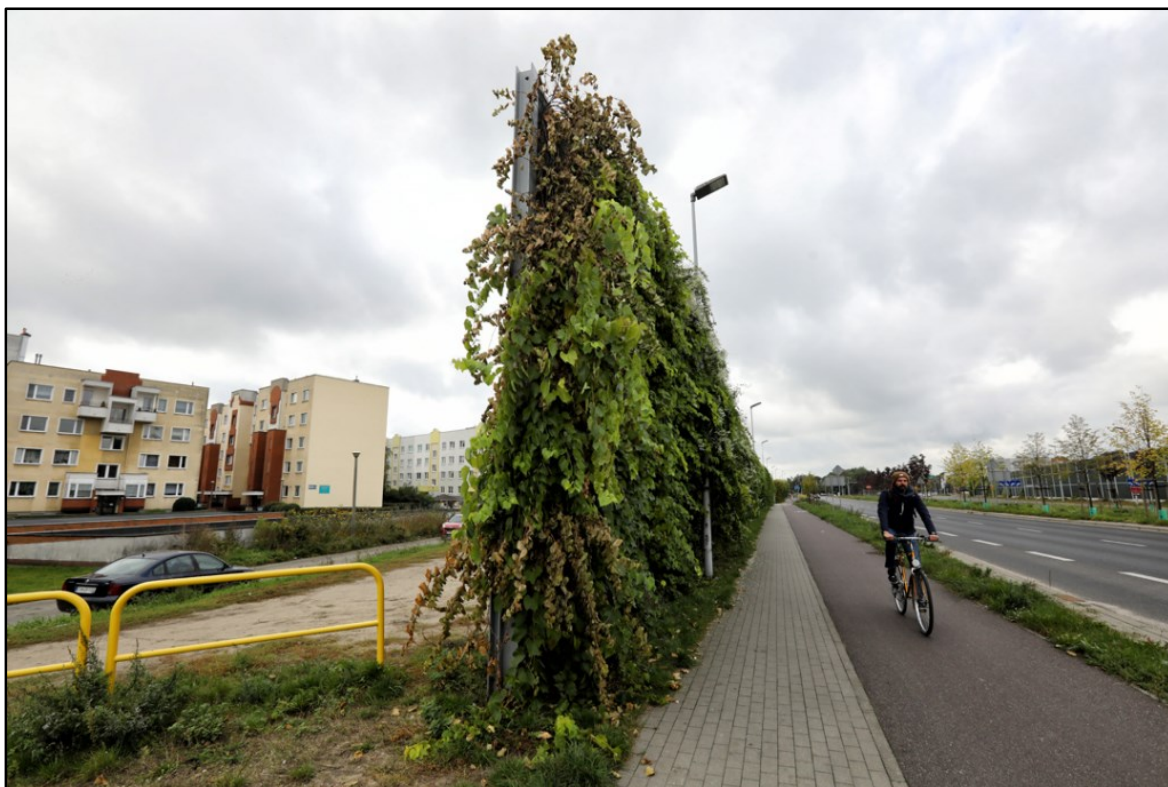
Fot. 50. Pnącza porastające ekran akustyczny
