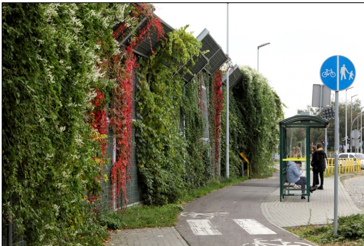
Fot. 49. Jesienne barwy ekranów akustycznych
