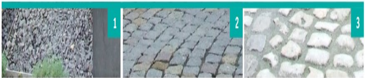
Ryc. 8. Rodzaje materiałów na nawierzchnie przepuszczalne: żwir (1), kostka kamienna na podbudowie piaskowo – żwirowej (2), bruk kamienny (3), źródło: Fundacja Sędzimira
