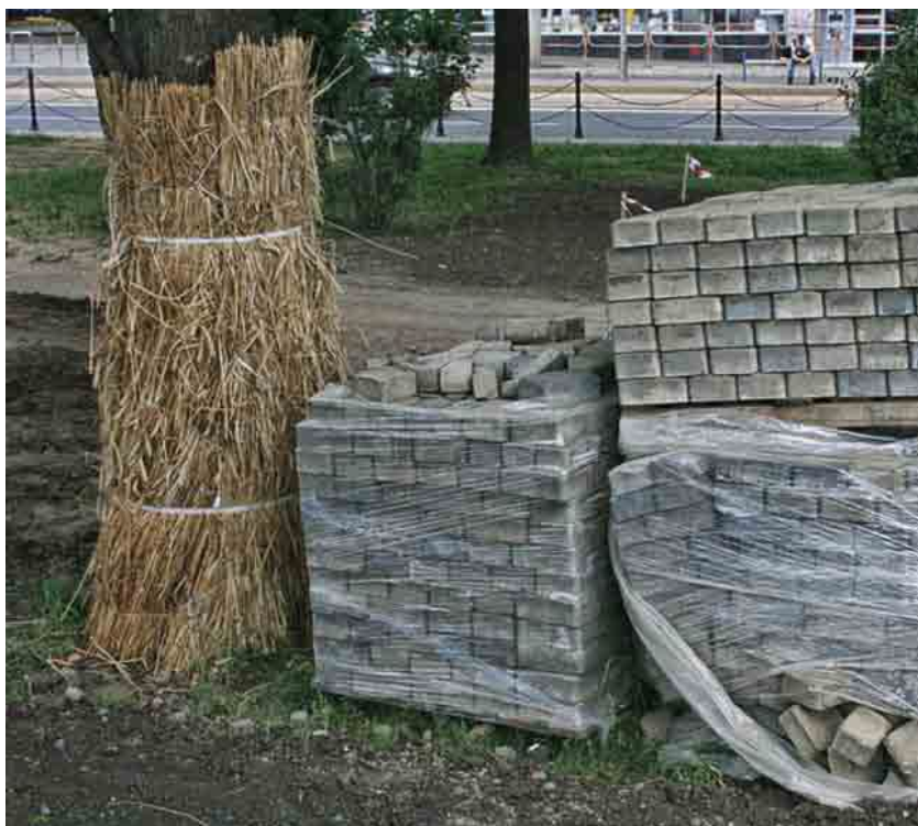
Fot. 3. Wadliwe zabezpieczenie drzewa (źródło: materiały własne Urzędu Miasta Krakowa)
